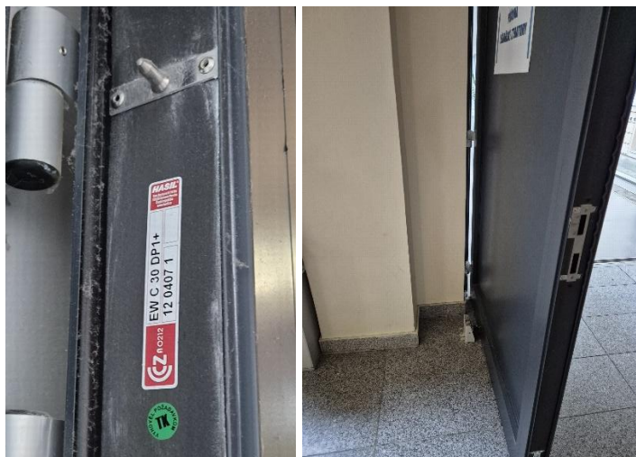
Obrázek 3: Požární dveře mezi objekty 1 a 2
